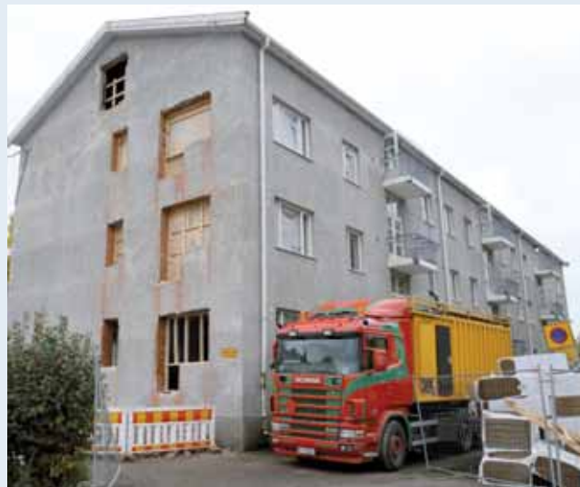
Koivukujan vanhat kiinteistöt puretaan peruskorjauksen alkuvaiheessa niin, että jäljelle jää lähestulkoon vain runko.
